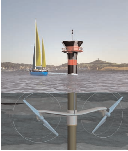
Wie ein abgetauchtes Windrad arbeitet die Gezeitenstromanlage Seagen
