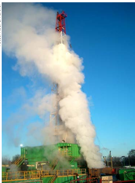
Bohren bis in dreieinhalb Kilometer Tiefe.
