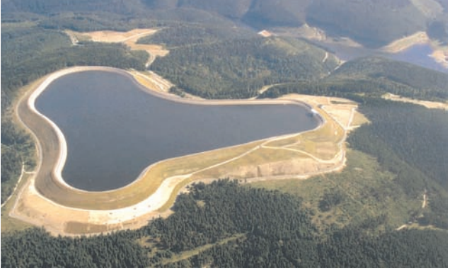
Das obere Becken des Pumpspeicher-Kraftwerks Goldisthal in Thüringen
