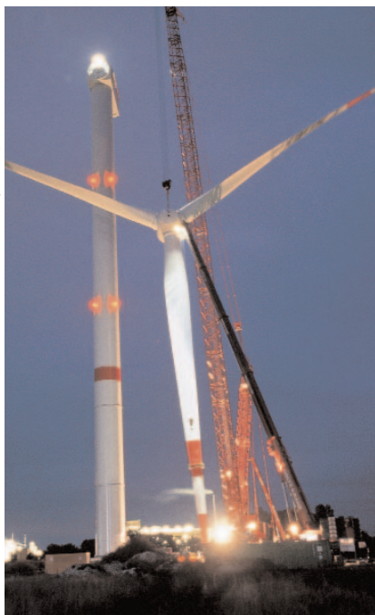
Während des Aufbaus: das weltgrößte Windrad REpower 5M
