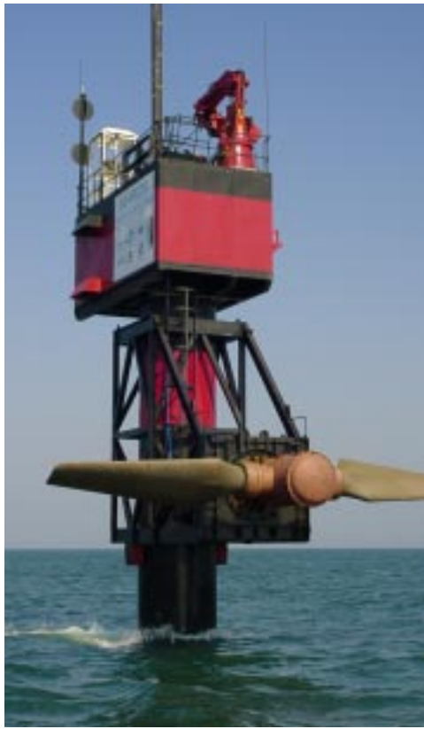
Die Spitze des im Meeresgrund einbetonierten Stahlturms von Seaflow – hier mit angehobenem Rotor – ragt aus dem Wasser hervor.
