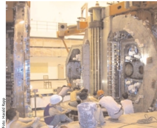
Wiederaufbau der Anlage - hier des Magnetsystems - in Chengdu.
