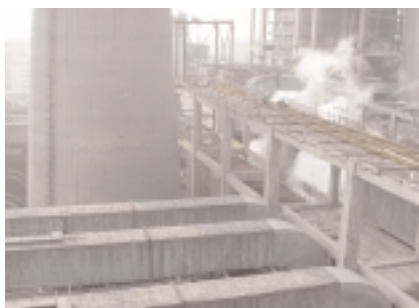
Das Kohlekraftwerk in Chongqing, Zentralchina, wird mit einer modernen Rauchgasentschwefelungsanlage nachgerüstet
